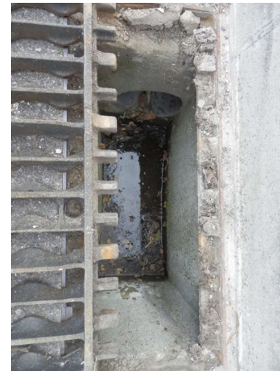
Avaloirs eaux pluviales et coffrets techniques
