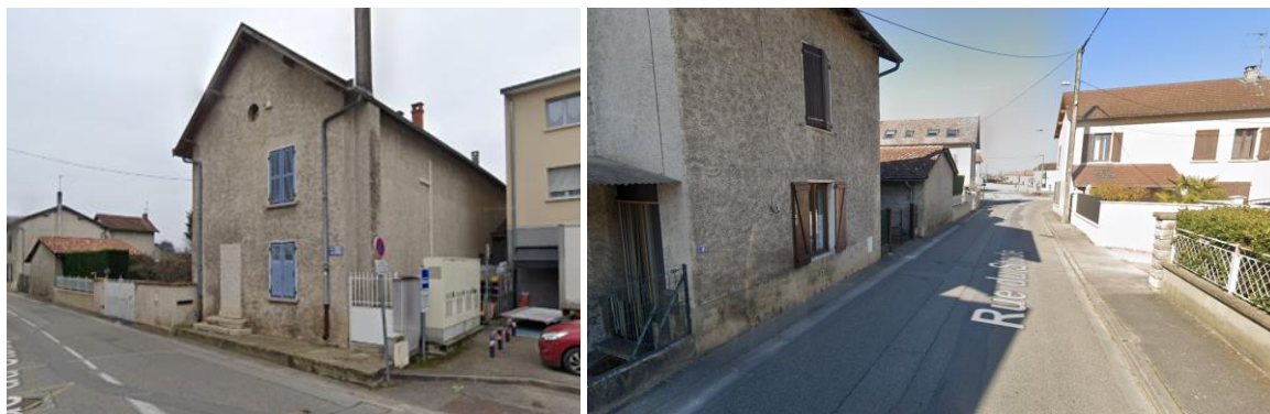
Vues sur le site depuis la rue du Stade
