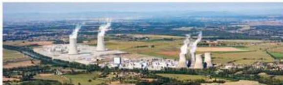
Deux tours aéroréfrigérantes
