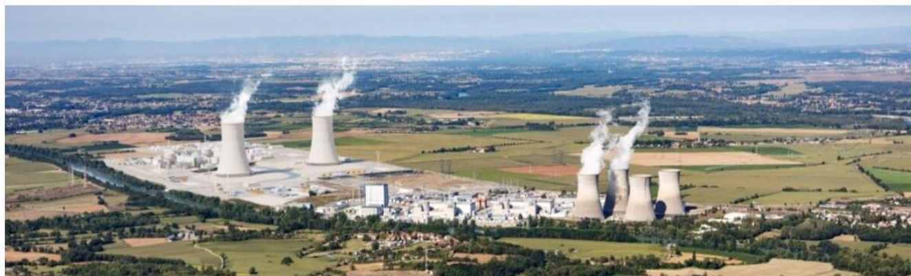
Deux tours aéroréfrigérantes
