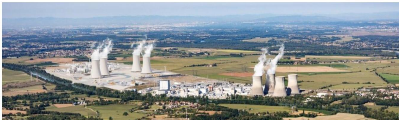
Quatre tours aéroréfrigérantes
